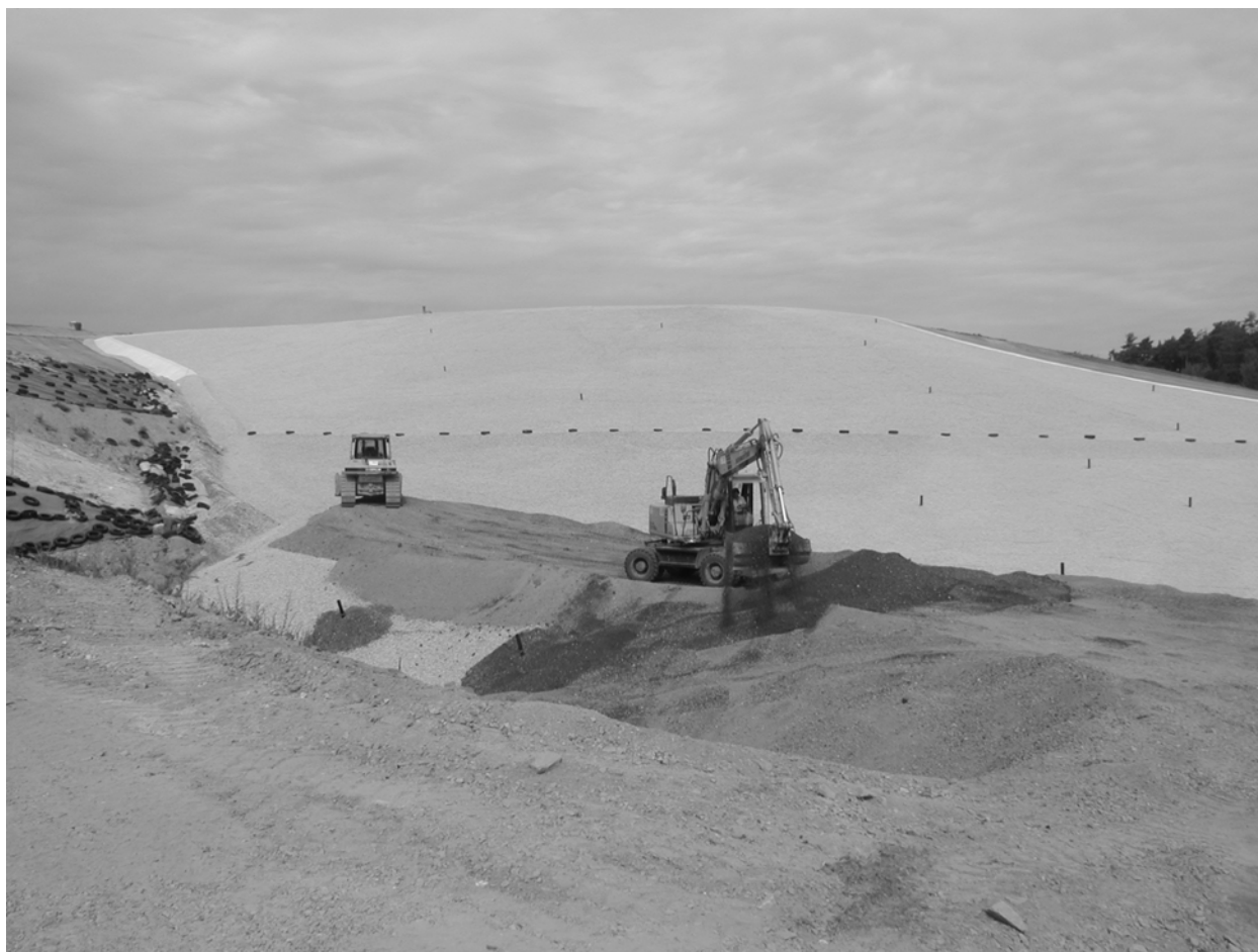
Abb. 4: Einbau der MVA-Schlacke als Ersatz für geotextile Schutzlage
